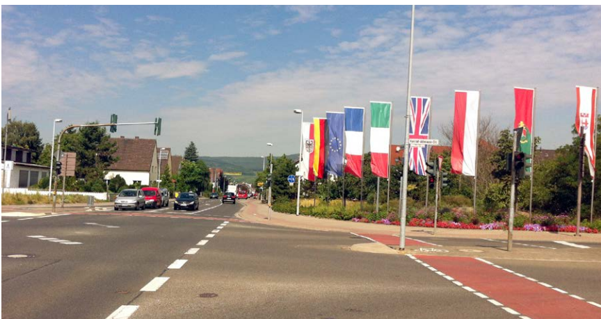
Kreuzung Rheinstraße/Konrad-Adenauer-Straße. Die Kapazität dieses Knotenpunktes ist in Kürze erschöpft! Die Warteschlangen werden länger werden.
